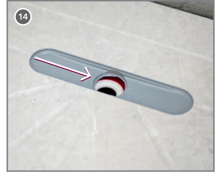
Sifonun aksa gelmesi için gider boşluğundan eksantrik ayarı yapılır. Perform eccentric adjustment from the drain gap to align the floor siphon with the axis.
