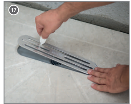
Kapak montajı yapılır. Install the cover.
