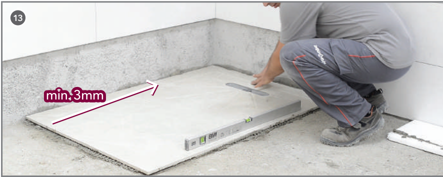
Aquanit Porselen Duş Karosu yerine konulur. Gidere doğru 2-3 mm eğim önerilir. Place Aquanit Porcelain Shower Tile. Beveling 2-3 mm towards drain is recommended.
