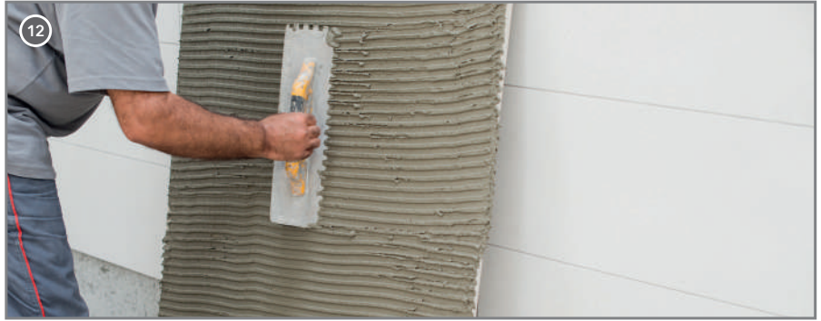
Aquanit Porselen Duş Karosu arkasına porselen yapıştırıcı sürülür. Apply porcelain adhesive to the back side of Aquanit porcelain shower tile.
